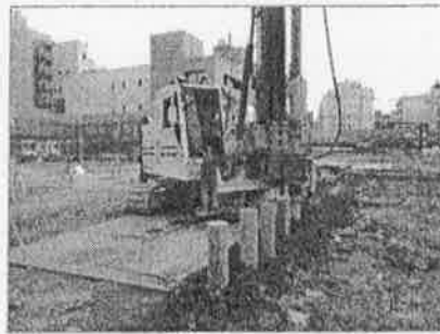
丸太杭工事は、約5ヶ月も続きました。
