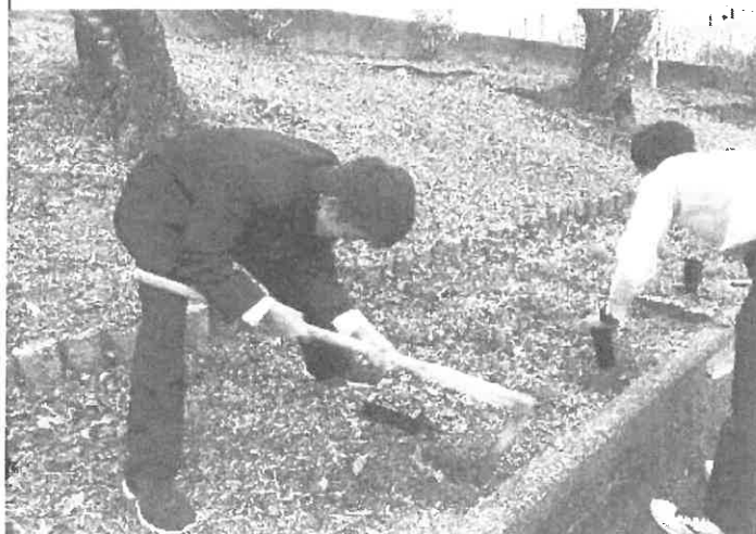
二種類のソーラーLEDイルミネーションの設置。 夜になると可愛いく光る道づくり。
