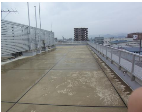
事務所棟屋上
