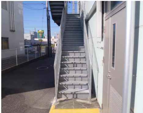
事務所棟外階段
