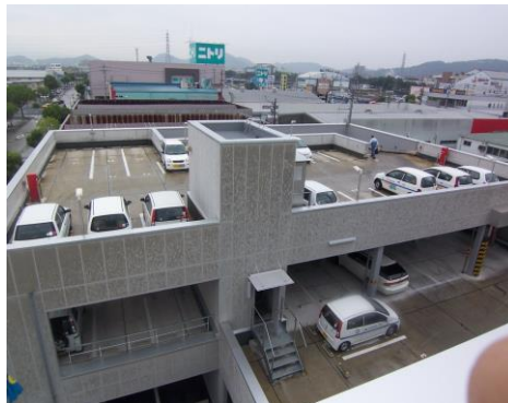
駐車場棟屋上
