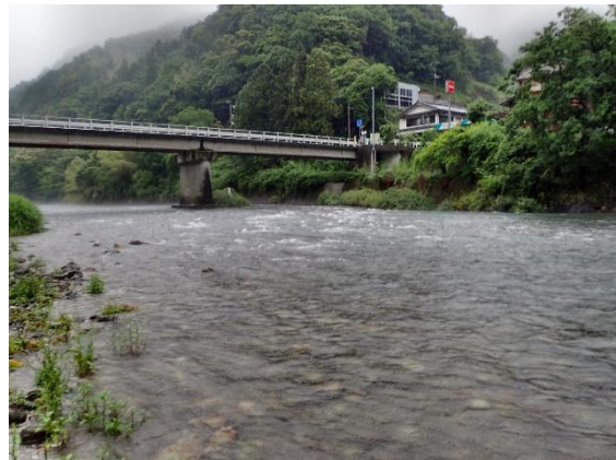
St. 15 (大河内橋)
