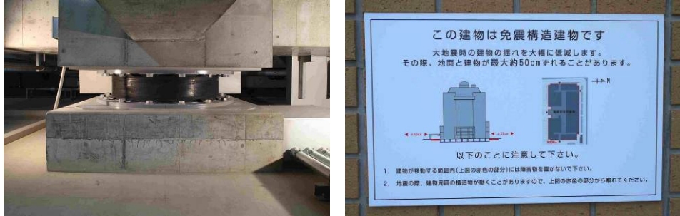
免震装置の設置イメージ
