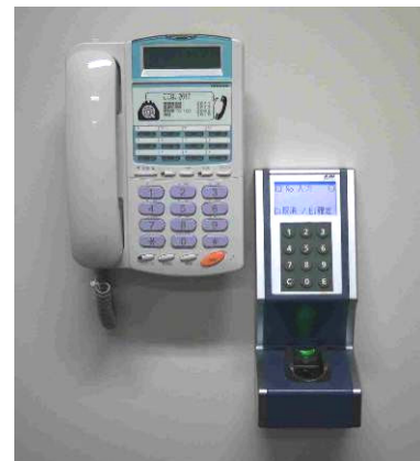
サーバー室出入管理(青梅市庁舎)
