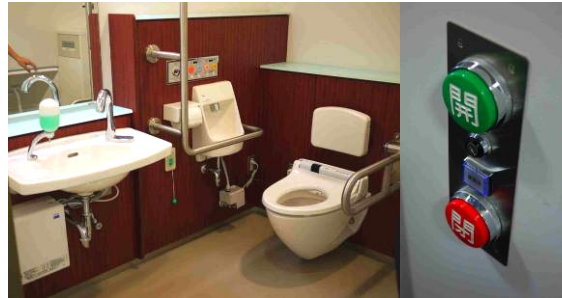
多目的トイレ(青梅市庁舎)
