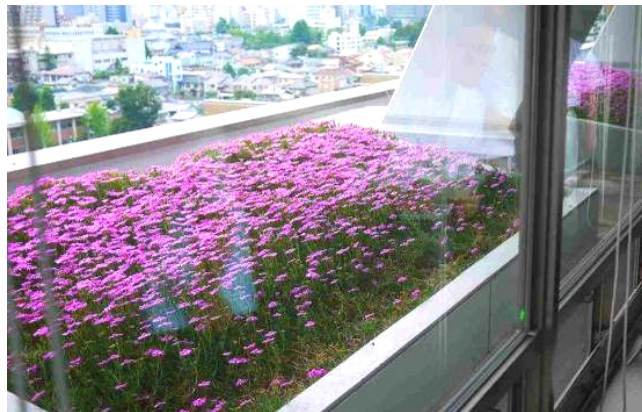
維持管理に配慮したプランター緑化(福島市庁舎)
