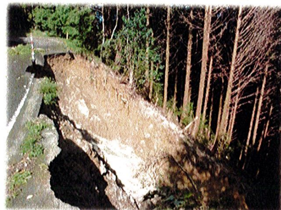
土佐山217号線 補強盛土 H=10.0m×L=17.0m
