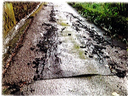
朝倉170号線 舗装工 W=4.0m×L=300.0m
