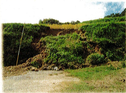
鏡大河内キタヤシキ農地(田) 畦畔工 L=7.0m H=5.0m
