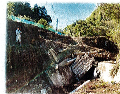
佐山川 護岸擁壁 H=3.0m×L=20.0m
