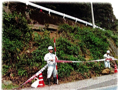
朝倉1号線 路側擁壁 H=9.0m×L=14.0m
