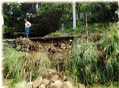
蓮台農道 路側修繕
