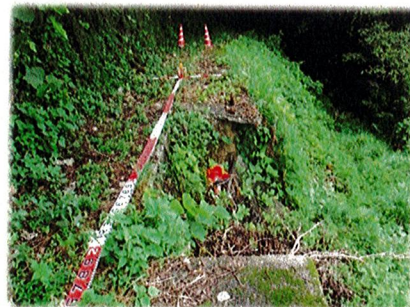
鏡139号線 路側擁壁 H=3.0m×L=7.0m
