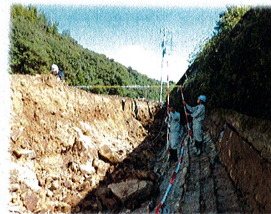
尾立川 護岸擁壁 H=4.5m×L=26.0m
