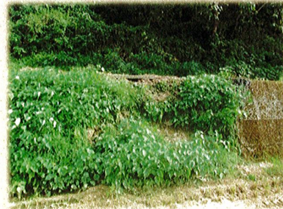
尾立農道 路側復旧工事
