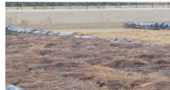
◀ 調整池の中央に設置された竹ソダ
