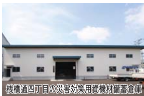
棧橋通四丁目の災害対策用資機材備蓄倉庫
