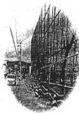
↑愛宕中 工事現場
