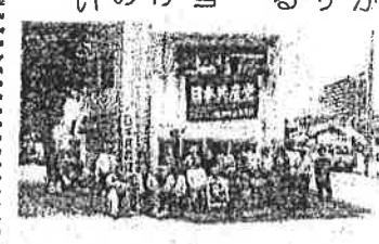
7月から解体作業に入る、すべり山の日本共産党事務所。先日の閉所せしモノーで。
