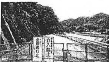
この先の土砂撤去も予算化されました
