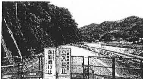
市内で5箇所、度しや崩れにより通行止めに=写真は、朝倉の行川地区
