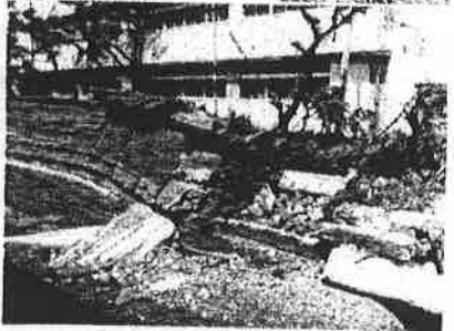
上) 区長さんから聞き取り 中) 1階部分の高さまで押し寄せた土砂 下) まるで地震・津波被害のような水のすさまじい破壊力
