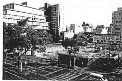
オーテピアの正面に高層の建築物はふさわしくない
