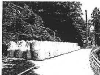
県道6号線は鏡小浜・ホケ坂で山腹崩壊が起きた
