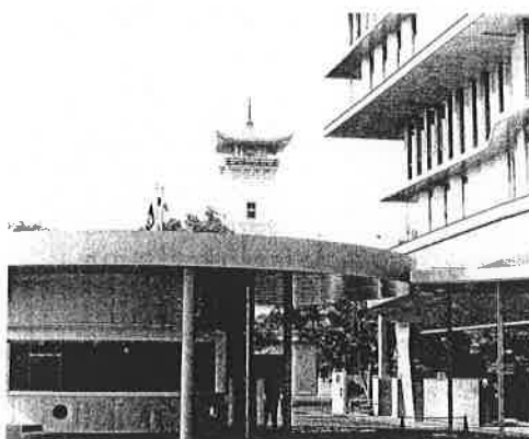
入り口の機械式地下駐車場には60台の駐車が可能で
