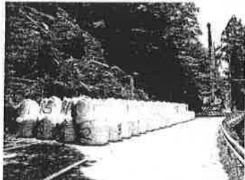
県道6号線は鏡小浜・ホケ坂で山腹崩壊が起きました
