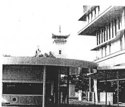
入り口の機械式地下駐車場には60台の駐車が可能で
