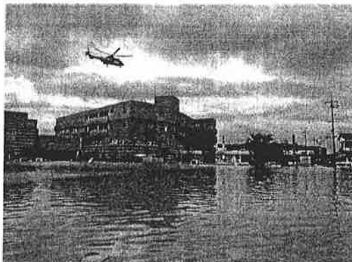
浸水した倉敷市真備町地区のまび記念病院（7月8日）
