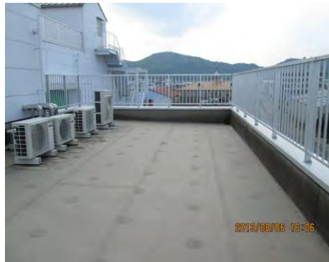
事務所棟屋上
