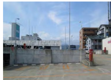
屋上スペース
