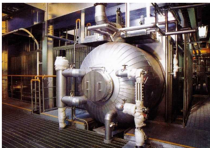
ボイラ（※資料は高知市提供）
