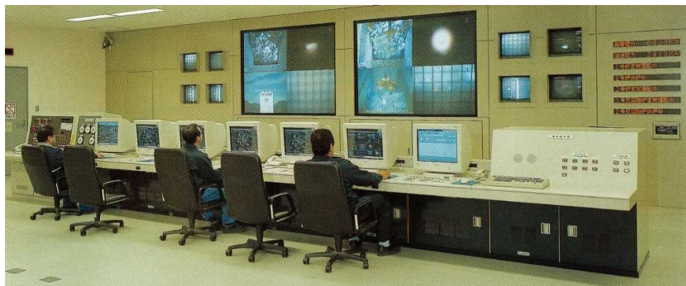
中央監視制御室（※資料は高知市提供）
