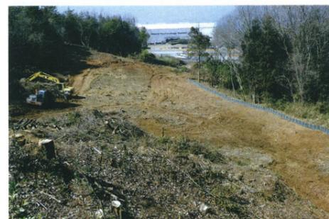
一時伐採区域（法肩部の仮設防災と調整池築造に必要な範囲の伐採）
