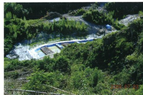
一時伐採範囲内（一時防災・仮設沈砂池・仮設道路に必要な範囲の伐採）
