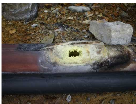
図 13 高濃度硫化水素を放出するガス抜き孔に析出した針状硫黄結晶
