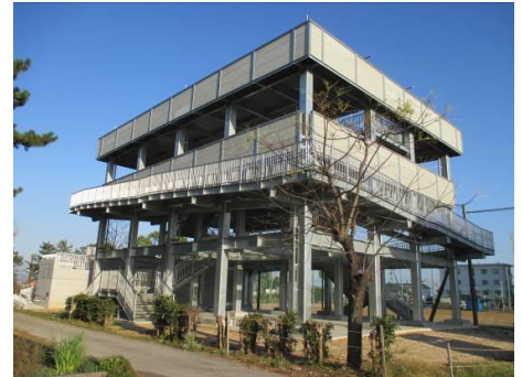
種崎公園津波避難タワー（三里地区）
