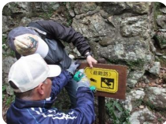
筆山津波避難路の整備
