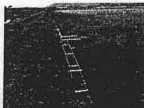
水田・水路間の魚類の移動を目指して設置された水田魚道
