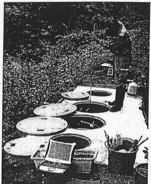
図-8 点検要領写真より
