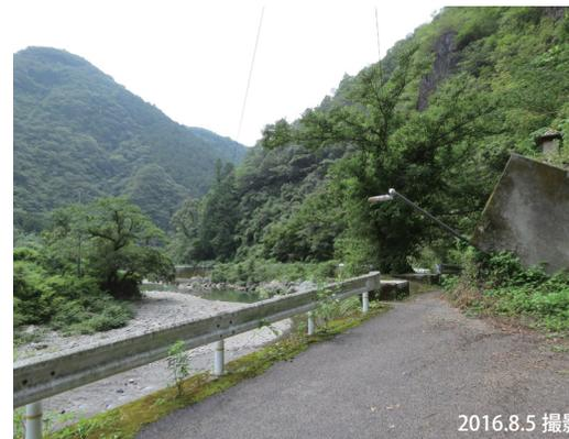
本体部分がなくなり、吊橋としての機能・価値は失われ、残存するコンクリート構造物が旧道を塞いでいる。過去に高知県によって、桑尾地区を含めた「まなびのみちづくり」が構想された経緯がある。上記の残存構造物を撤去することができれば、大穴峡を含めたエリアの散策ルートとして機能を回復でき、新たな候補地となりうる。
