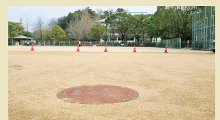
マンホール下に貯水槽が設置されています。
