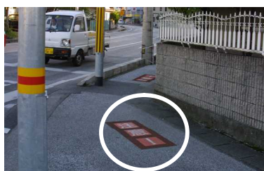
危険表示設置（介良）
