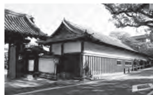
15 旧山内家下屋敷長屋展示館
