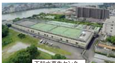
下知水再生センター
