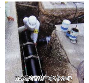
配水管布設替工事(与力町)
