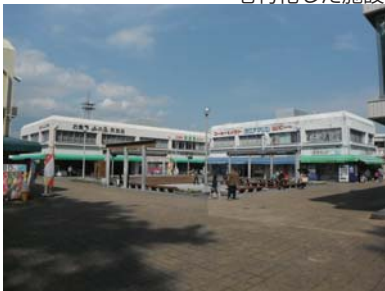
老朽化した施設
