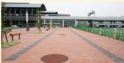
中央のマンホール下に貯水槽が設置されています。
