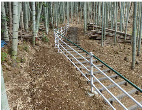
整備された津波避難路
