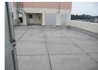
屋上避難スペース
