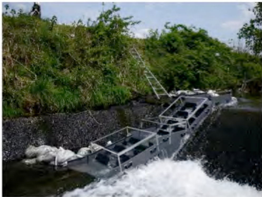
堰堤前面に直接とりつけ
