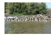
【須崎市新荘川 下郷堰の魚道】 下郷堰の魚道は、扇状のスロープに大小 の石を配して、魚道の入口が魚にわかり やすい(どこからでも避してきる)よう に作られています。
