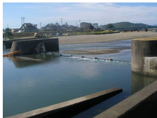
廓中堰ゲート全倒時の状況 (平成 19 年 10 月)
