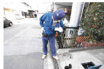
昼夜おこなわれている漏水調査。道路からメーターまでの戸別調査では、メーター部に音調棒をあてて調査をします。
