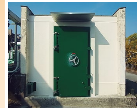
水再生センターの津波防水化工事
