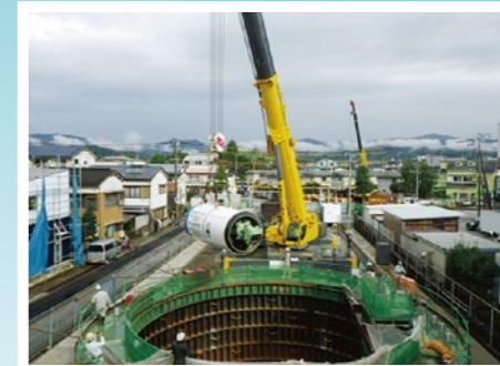
発進立坑に下ろされるシールドマシン
