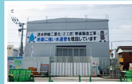
騒音などの対策として、防音ハウス設置
