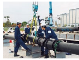
水道管の復旧訓練
