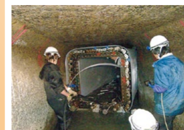
第一分区分合流幹線の耐震補強工事
