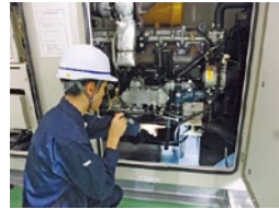
施設の点検や調査
