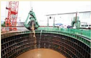
現在は、工区を5つに分けたうちの2工区目の工事が、去年末から進行中です。朝倉配水所の敷地内には、大きな縦穴が完成しており、今後この縦穴に「シールドマシン」と呼ばれる機械を下ろし、針木浄水場のふもとの県道までの約2kmの管路を掘り進める作業を進めます。2工区は平成28年度に完了する予定で、九反田までの二重化が完了するのは平成32年度の予定です。
