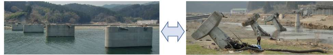
津波の影響に対する橋の破壊形態 (2011年東北地方太平洋沖地震)
