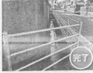
③初月校区通学路転落防止柵設置
