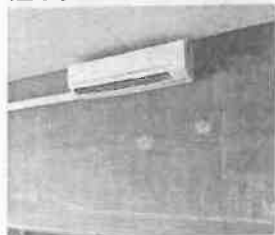
高知市営球場 選手控室に空調設備設置
