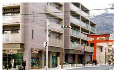
再建された建物(全周化毛)の状況
