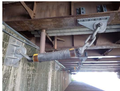
(橋桁下の落橋防止装置)
