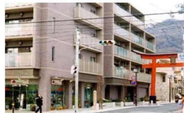
再建された建物(全周化毛)の状況
