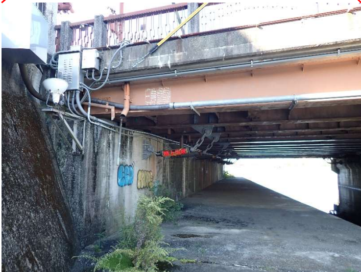
(橋桁下の落橋防止装置)
