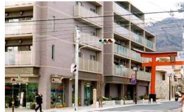
再建された建物(全周化宅)の状況
