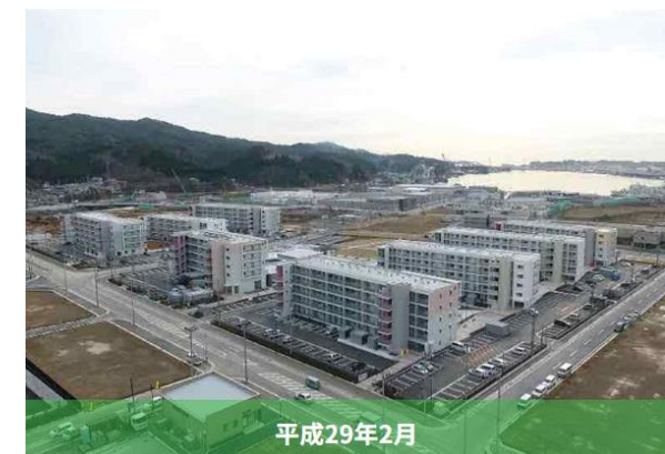
宮城県鹿折地区（復興庁HPより）
