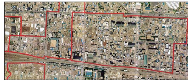
震災後 平成7年5月
