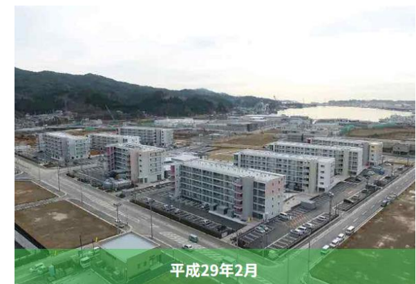
宮城県鹿折地区（復興庁HPより）
