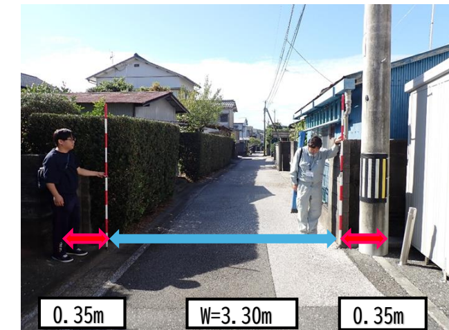
④道路幅員(南向きに撮影)W=3.30m
